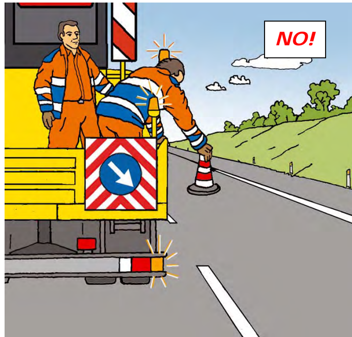
Figura 60 – Posizionamento dei coni o defleco: comportamento scorretto
