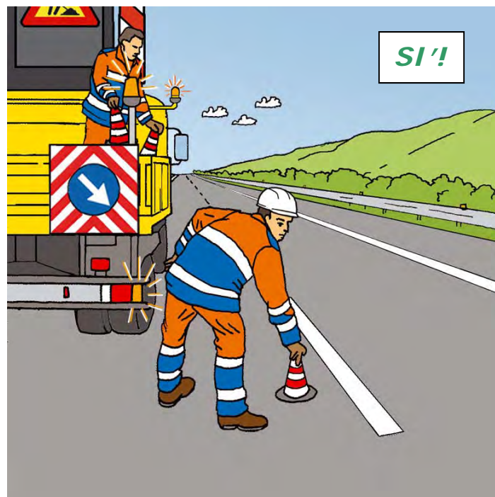
Figura 59 – Posizionamento dei coni o defleco: comportamento corretto
