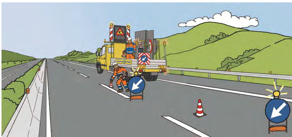
Figura 33 – Chiusura della corsia di marcia: inizio della posa dei coni
